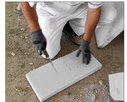
Schalung aus z. B. EPS-Dämmplatten
