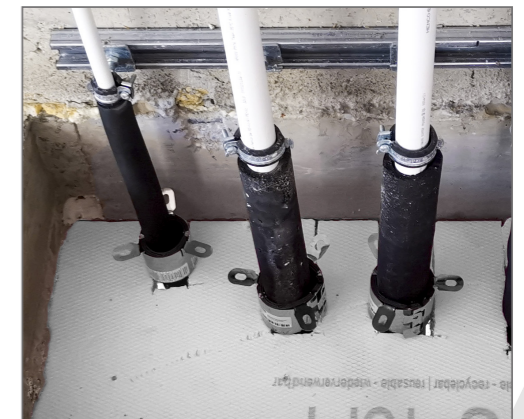
Brandschutzmanschetten RORCOL auf Schalung aufgesetzt
