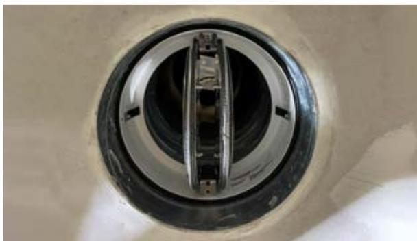
Cette norme européenne définit un procédé pour déterminer la durée de résistance au feu des clapets coupe-feu montés dans des éléments séparatifs résistants au feu et prévus pour résister au passage de feu, de fumée et de gaz à température élevée. Cette norme européenne s'applique en association avec la norme EN 1363-1.
